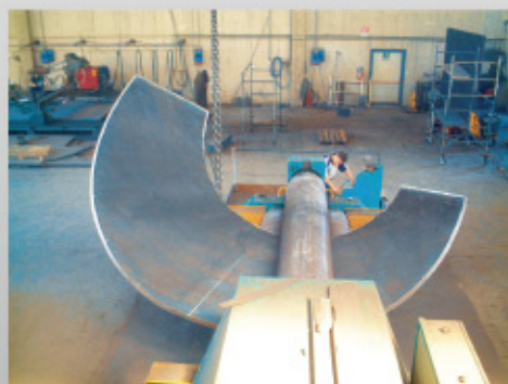
将变宽度的钢板卷制成大顶角的锥管
